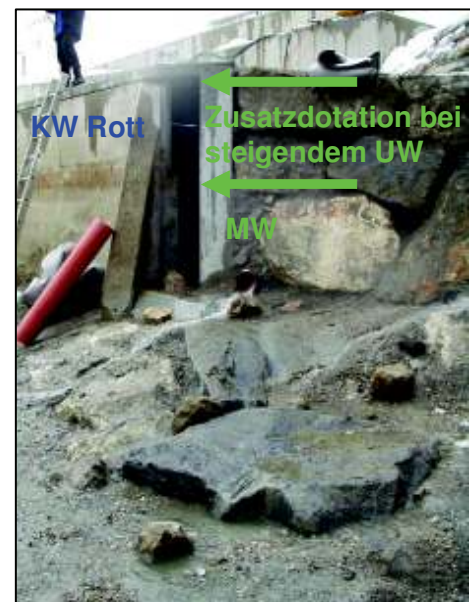
Abbildung 48 und Abbildung 49: Sohlbindung im Unterwasser im Bereich des Turbinenauslasses durch ansteigende Rampe mit rauer Sohle, KW Werfen, Salzach (links) und Sohlbindung im Unterwasser an natürliche Sohle, im direkten Bereich des Einstieges befestigt, KW Rott, Saalach; ersichtlich ebenfalls die Lage des Unterwasserspiegels bei unterschiedlichen Wasserführungen und die daraus abgeleitete Notwendigkeit einer dynamischen Zusatzdotierung zur Aufrechterhaltung der Ausströmgeschwindigkeit und damit der Auffindbarkeit (rechts) (JÄGER und ZITEK 2009).
