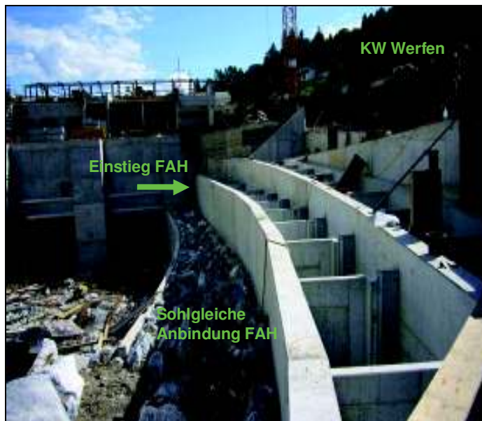
Abbildung 48 und Abbildung 49: Sohlbindung im Unterwasser im Bereich des Turbinenauslasses durch ansteigende Rampe mit rauer Sohle, KW Werfen, Salzach (links) und Sohlbindung im Unterwasser an natürliche Sohle, im direkten Bereich des Einstieges befestigt, KW Rott, Saalach; ersichtlich ebenfalls die Lage des Unterwasserspiegels bei unterschiedlichen Wasserführungen und die daraus abgeleitete Notwendigkeit einer dynamischen Zusatzdotierung zur Aufrechterhaltung der Ausströmgeschwindigkeit und damit der Auffindbarkeit (rechts) (JÄGER und ZITEK 2009).
