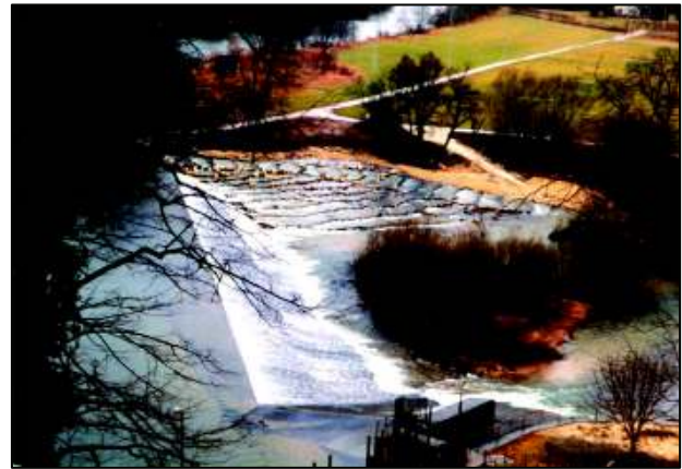
Abbildung 3: Aufgelöste Sohlrampe links (Foto: EZB) und Abbildung 4: Teilsohlrampe rechts (GEBLER 2009).
