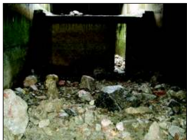
Abbildung 39 und Abbildung 40: Beispiele der baulichen Umsetzung der rauhen Sohle Fließgeschwindigkeit (links, Foto: LEHMANN) (rechts, Foto: SALZBURG AG) (JÄGER und ZITEK 2009).
