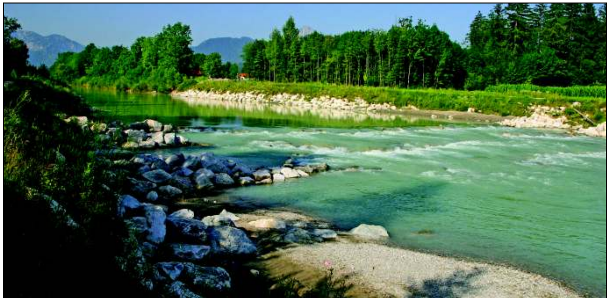
Abbildung 5: Aufgelöste Sohlrampe, deutlich sind die am Rand hochgezogenen Querriegel zu sehen, die eine Passierbarkeit der Rampe auch bei Hochwasser sicherstellen sollen (Foto: P. JÄGER).
