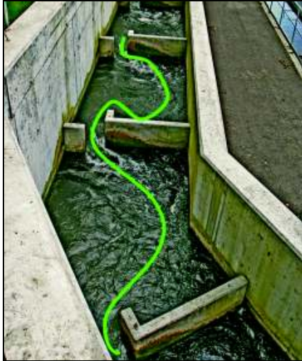
Abbildung 20 und Abbildung 21: Schlitzpass („Vertical slot“) mit der erforderlichen Strömungsausprägung (links) (JÄGER und ZITEK 2009) und 3-dimensionales Strömungsmodell eines Schlitzpasses (HEIMERL und HAGMEYER 2005).
