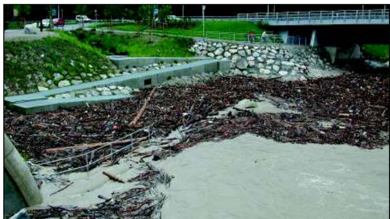
Abbildung 44 und Abbildung 45: Massiver Eintrag von Geschwemmsel in einen Schlitzpass (links, Foto: A. LUNARDON) und Treibgutbelastung im unterwasserseitigen Einstiegsbereich des KW Rott, Saalach (rechts, Foto: Salzburg AG).
