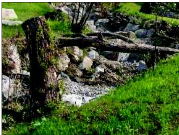
Abbildung 16 und Abbildung 17: Kristeinerbach, Sohlrauigkeit und bis zur Sohle durchgehende raue Beckenübergänge, Beschattung und Unterstände durch austriebsfähige Weidenstöcke vor und nach Flutung (Bauaufsichtsbericht Kristeinerbach, ULLMANN 2008).
