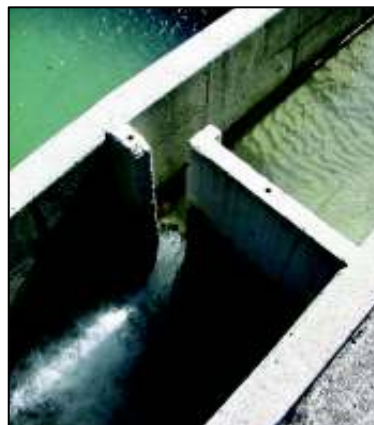
Abbildung 31 und Abbildung 32: Typische Verklauungsprobleme bei Schlitzpässen, weshalb von allen Autoren auf die Wahl einer ausreichenden Schlitzweite hingewiesen wird (beide Fotos: A. LUNARDON).
