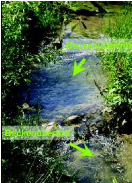
Abbildung 14 und Abbildung 15: Beispiele naturnaher Beckenpässe (Tümpelpass, Fotos: EZB)
