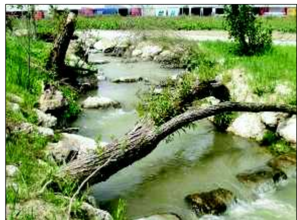
Abbildung 16 und Abbildung 17: Kristeinerbach, Sohlrauigkeit und bis zur Sohle durchgehende raue Beckenübergänge, Beschattung und Unterstände durch austriebsfähige Weidenstöcke vor und nach Flutung (Bauaufsichtsbericht Kristeinerbach, ULLMANN 2008).
