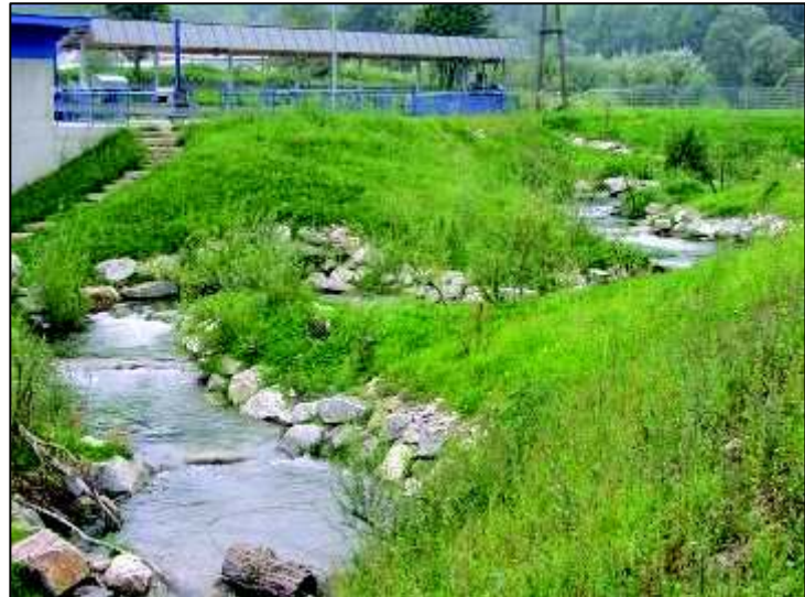
Abbildung 14 und Abbildung 15: Beispiele naturnaher Beckenpässe (Tümpelpass, Fotos: EZB)
