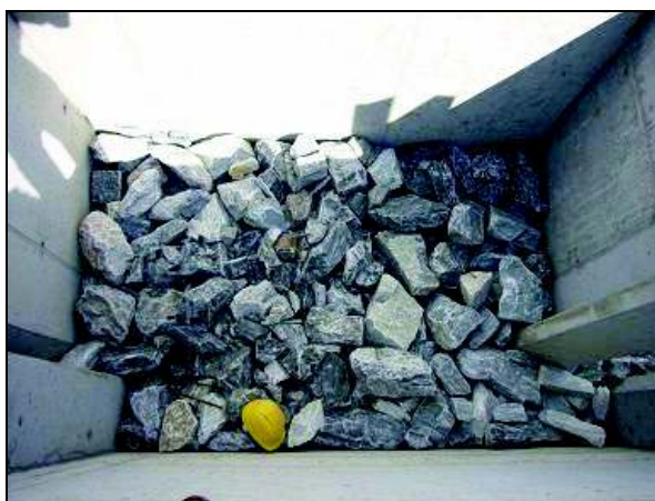
Abbildung 39 und Abbildung 40: Beispiele der baulichen Umsetzung der rauhen Sohle Fließgeschwindigkeit (links, Foto: LEHMANN) (rechts, Foto: SALZBURG AG) (JÄGER und ZITEK 2009).
