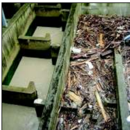
Abbildung 44 und Abbildung 45: Massiver Eintrag von Geschwemmsel in einen Schlitzpass (links, Foto: A. LUNARDON) und Treibgutbelastung im unterwasserseitigen Einstiegsbereich des KW Rott, Saalach (rechts, Foto: Salzburg AG).
